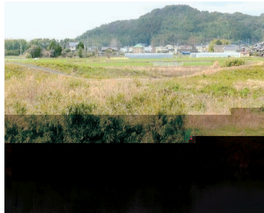
写真1 城原川の野越、堤防の真ん中が下がっている
