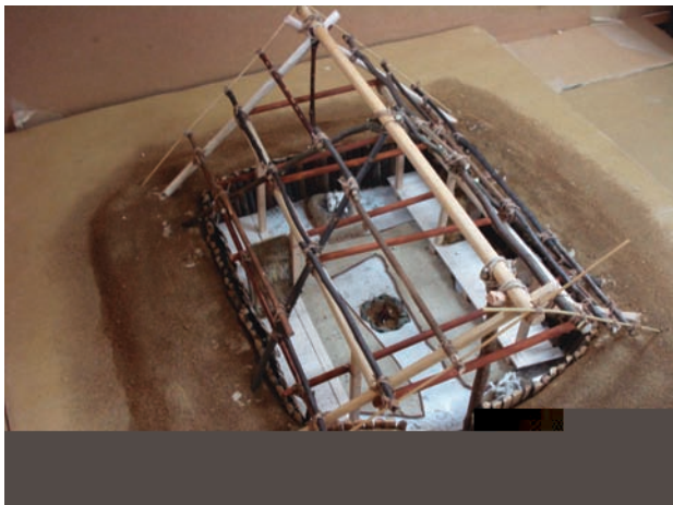
図22 模型制作プロセス 母屋取付
