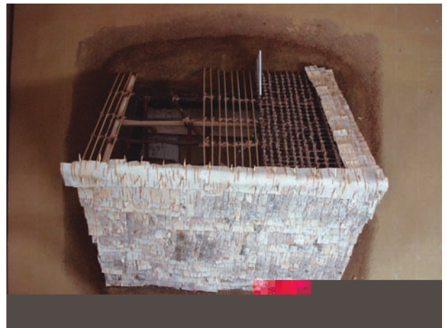
図25 模型制作プロセス 樹皮葺
