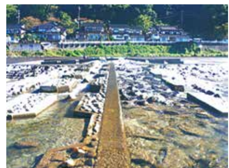
図2 大口堰の魚道の写真
