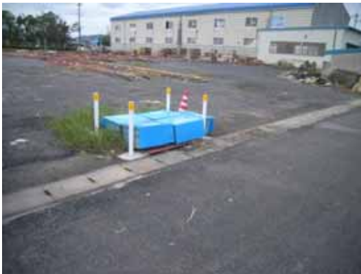
写真 5-1 一次保管容器設置場所
